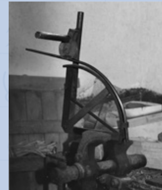
1959 – Das Biegen der Rohre erfolgt per Muskelkraft an selbst-konstruierten Werkzeugen.
